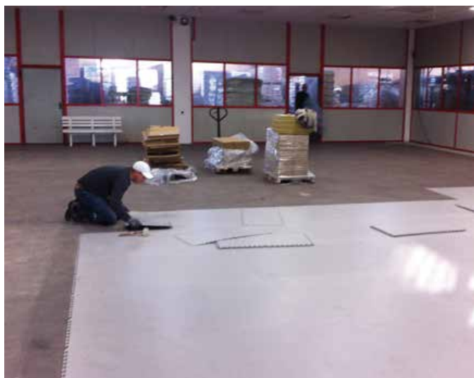
La fase di posa / Installation phase
